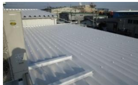
屋根への遮熱塗装
