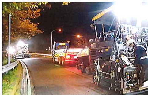
舗装補修工事 作業状況
