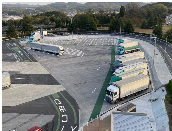
拡張した大型車エリア(E2 山陽道 福山 SA(下り)) ※2021年4月時点(一部箇所工事中)
