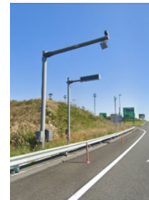
路車間無線通信機器 (フリーフローアンテナ)
