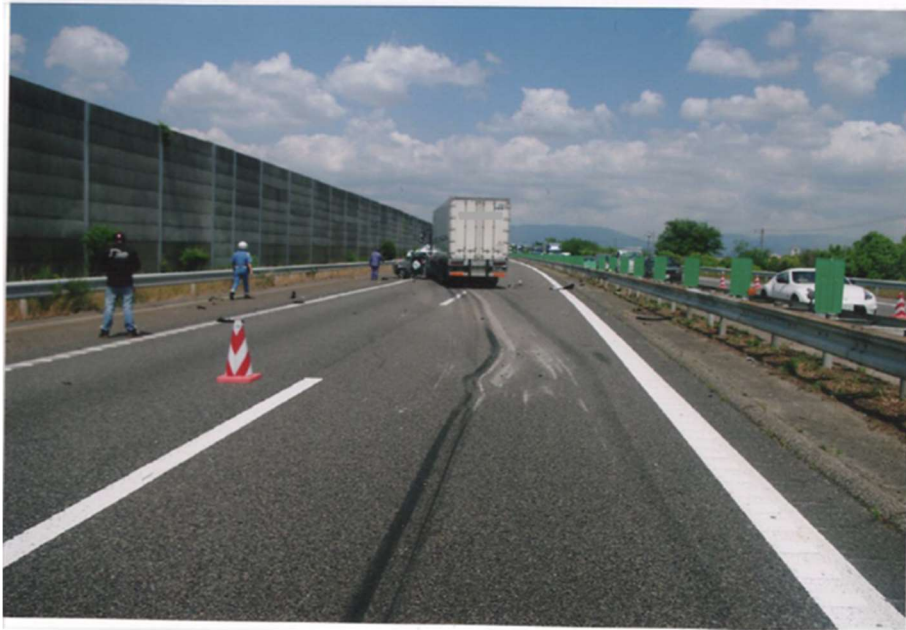
写真5 事故地点付近
