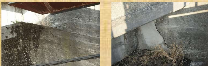
橋台のひび割れ
