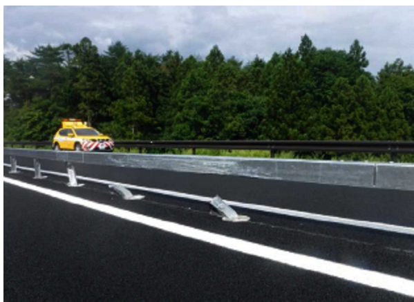
▲中央分離帯の損傷イメージ
