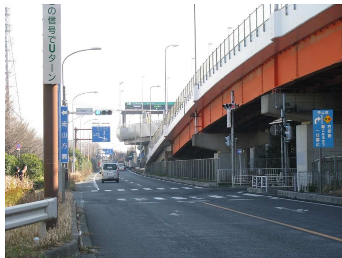
③ 撮影方向:南東 片側2車線 右折レーンあり
