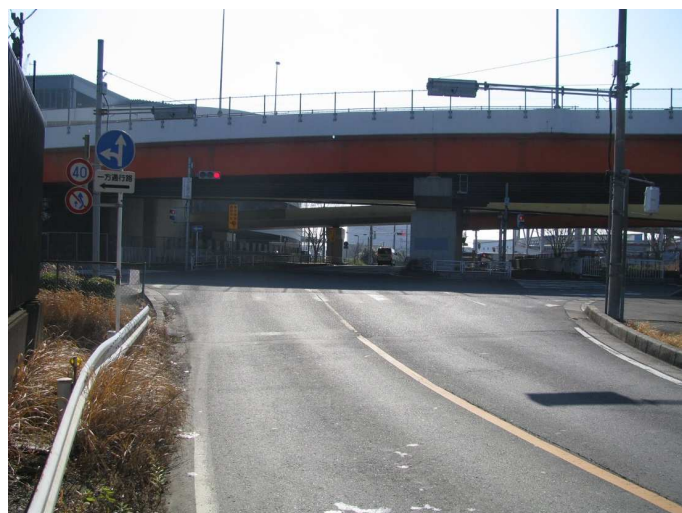
④ 撮影方向:南西 片側1車線
