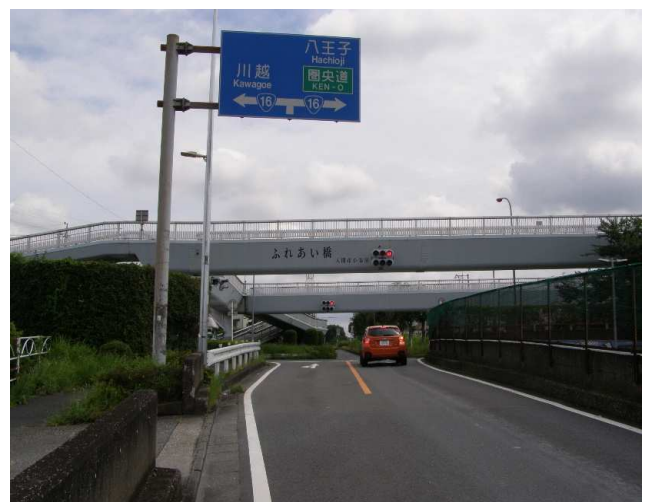
⑤ 撮影方向:南東 片側1車線 右折レーンあり
