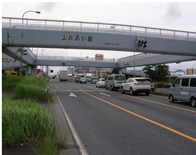
② 撮影方向:南西 片側2車線 右折レーンあり
