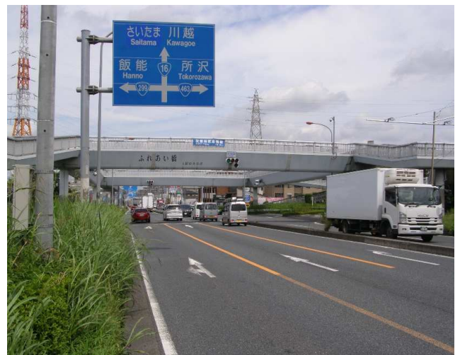
③ 撮影方向:北東 片側2車線 右折レーンあり
